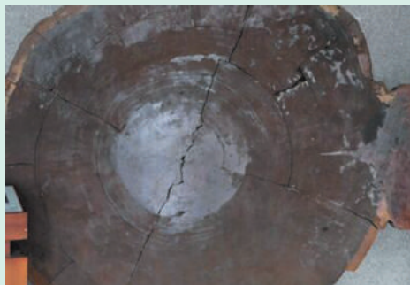
▲ 世界爺神木進行填料修復
